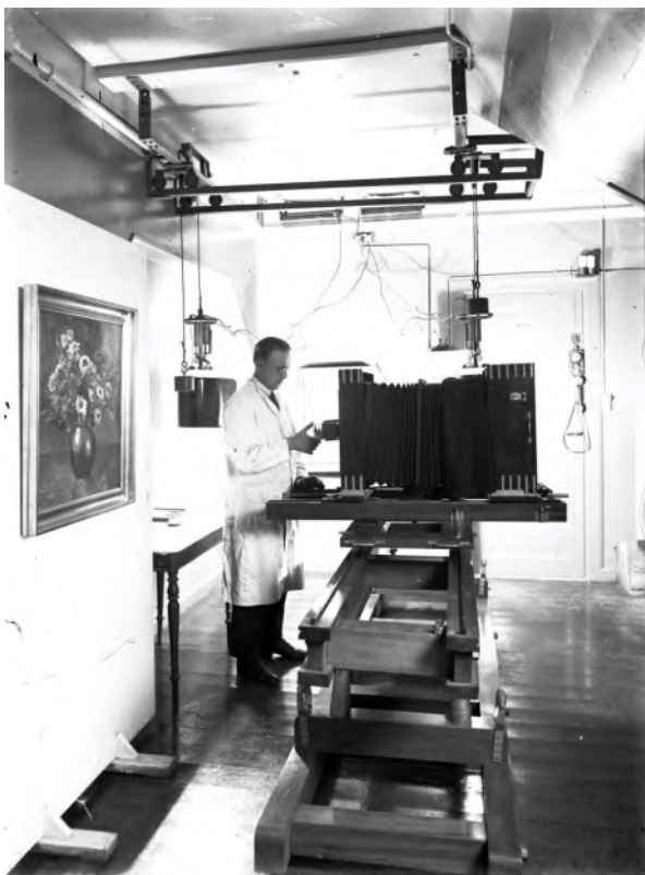
Reprokamera 50x60 format med lamper. Kameraet er drejet til siden.
