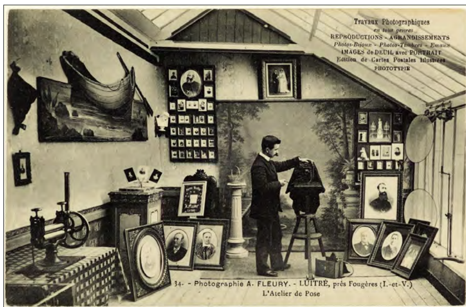
Fransk atelier med robåd på væggen.
