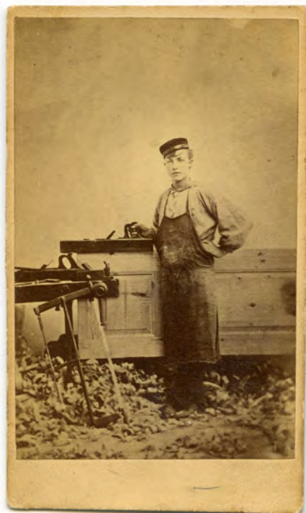
Snedkersvend med sit vigtigste værktøj: to rubanke, en slethøvl og rammesaven. Han er ved at færdiggøre en dør. H. Scharff, fotograf fra 1866 til 1875 i Gothersgade, Fredericia. Et af Gerhards ældste arbejderbilleder.
