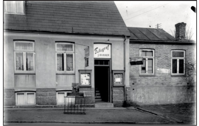
Store Gade 12 i Svaneke, på hjørnet af Munkegade. Købmand Jens Chr. Hansen opførte ejendommen i 1896. Ateliet i en tilbygning til højre blev bygget i 1916. Købmanden var far til fotografene Karen Hansen og Jenny Nyholm Olsen. Johs. Hammer overtog Karen Hansens fotoforretning og atelier i Storegade 12 i Svaneke 1. juni 1933.
