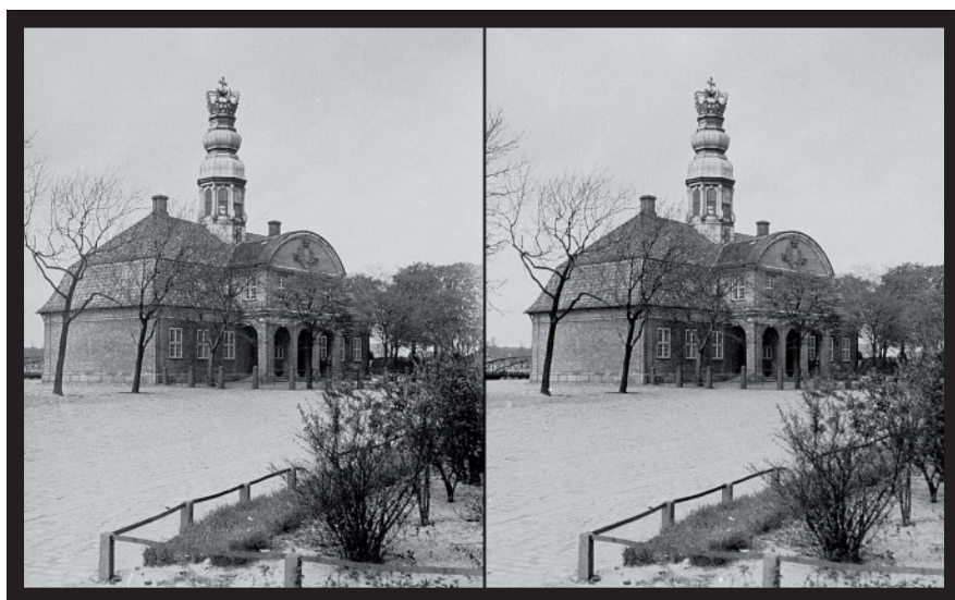
Administrationsbygningen på Orlogsværftet
