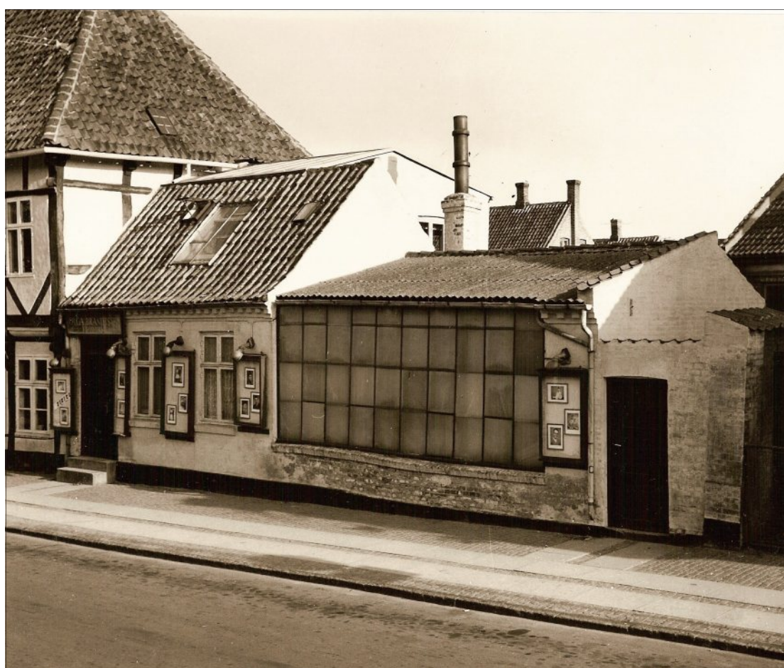
Olga Brandts efterfølger, Kalundborg. Atelieret nedrevet 1963
