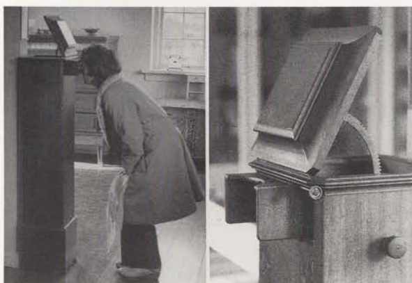
Et af Jens Poul Andersens store stereoskopbetragtere der findes på Nordsjællandsk Folkemuseum. På undersiden af toplåget er anbragt et spejl således at lyset kan falde på billederne, som er anbragt på et kædearrangement.
