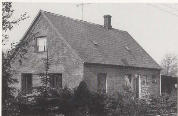
Efter tre års arbejde kunne bolig og værksted tages i brug omkring århundredskiftet. Indenfor de to vinduer i gavlen havde J.P.A. indrettet værksted.
