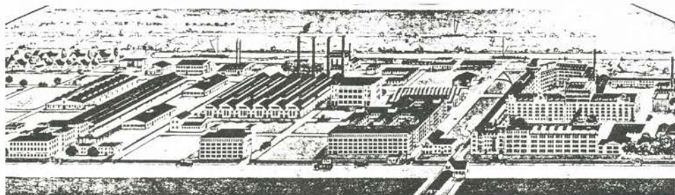
Fabrikanlagen der Goerz-Werke in Berlin-Friedenau und Zehlendorf.
