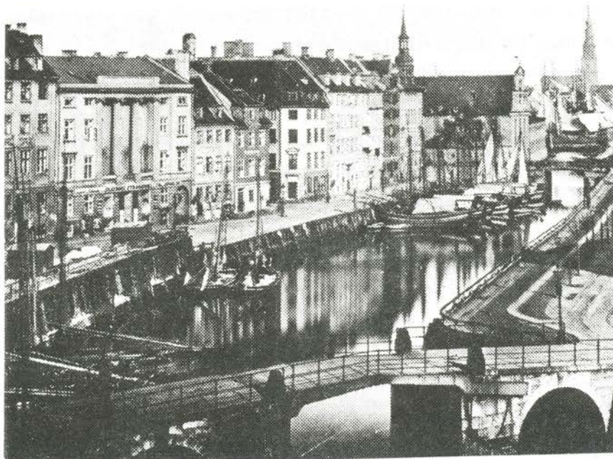
Facaderækken fra Holmens Kanal forbi Boldhusgade til Domus Technica. Udsnit af fotografi fra ca. 1865.
